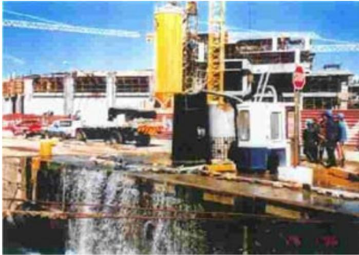
**barrera filtrante** en el caso de cualquier escape de petróleo mientras se recambiaba el BMG del tanque.
